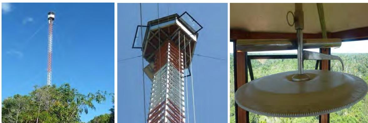
**Figura 111:** Torres de monitoramento de eventuais focos de incêndio no Parque Nacional do Descobrimento: detalhes da Torre Sul (Nova) com seus 42 m, placa solar para rádios HT e goniômetro (Fotos: Aristides S. G. Neto).
