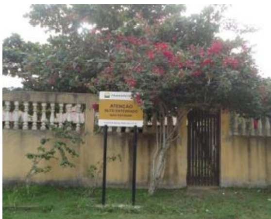
Figura 12: Placa de sinalização do gasoduto em frente de uma moradia em Sauê.
